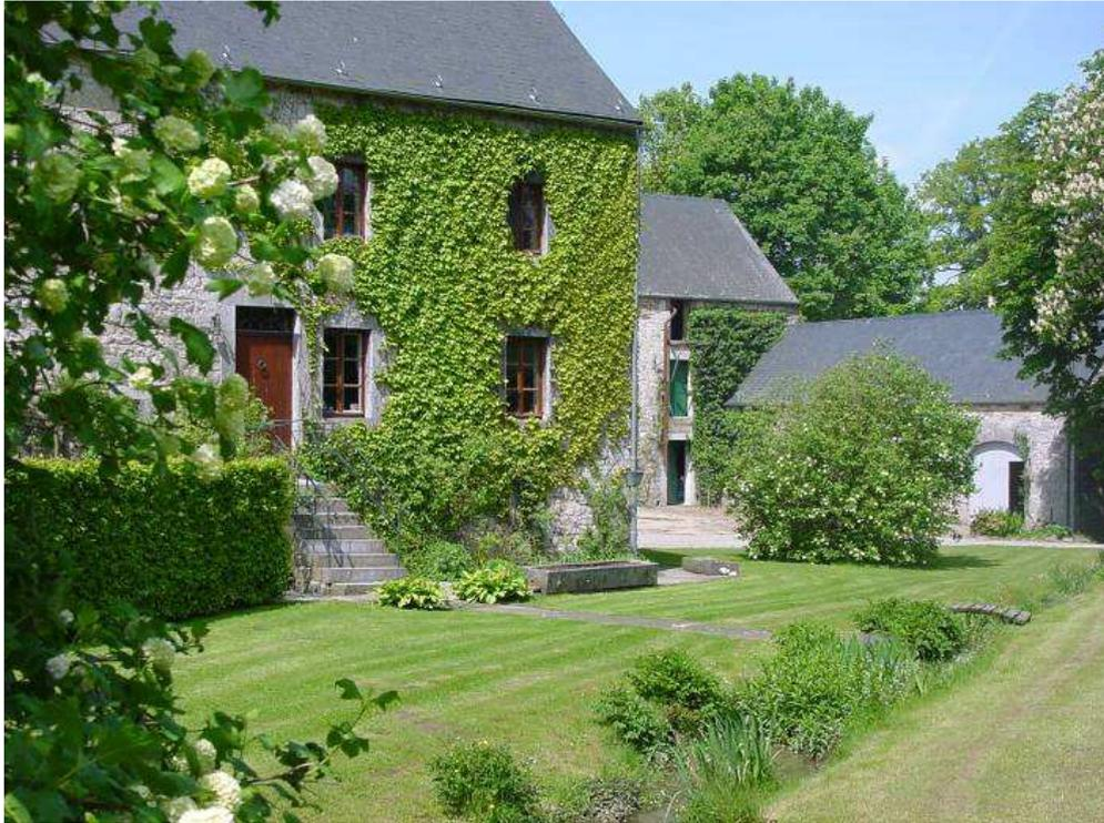
Ferme. Disposés de part et d'autre d'une ancienne fumière, bâtiments parallèles, bordés d'une aire pavée, de deux niveaux, datant de la seconde moitié ou du milieu du XVIII<sup>e</sup> s, en moellons calcaires assises, cantonnés de besaces et remaniés.
